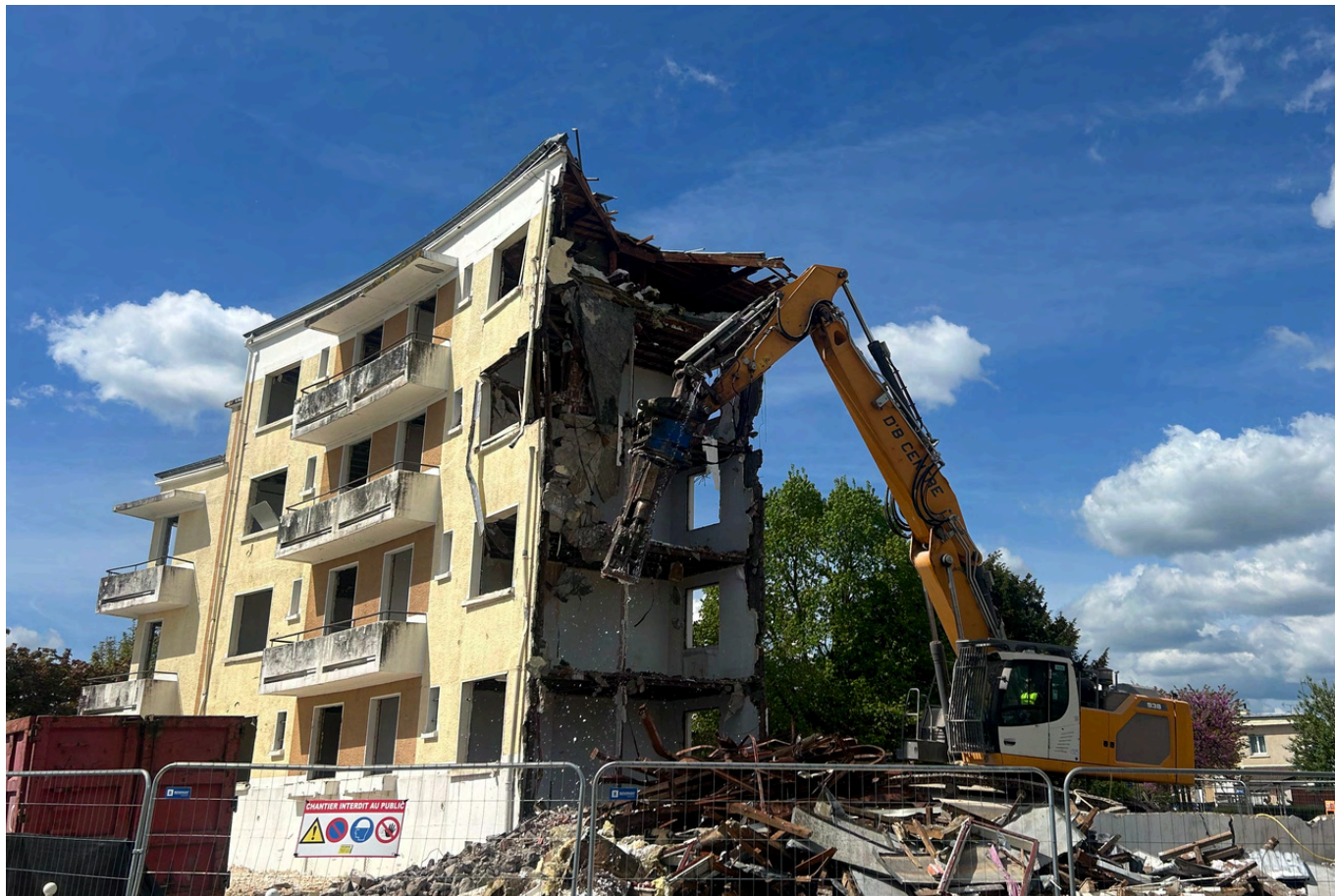
Dernières démolitions - juin 2026 - Val de Berry
