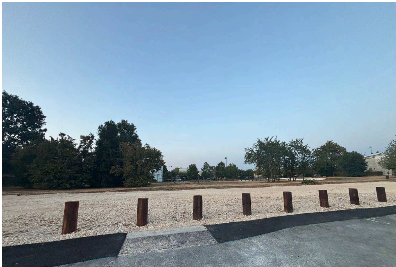
Fin de la démolition du quartier - juillet 2026 - Val de Berry
