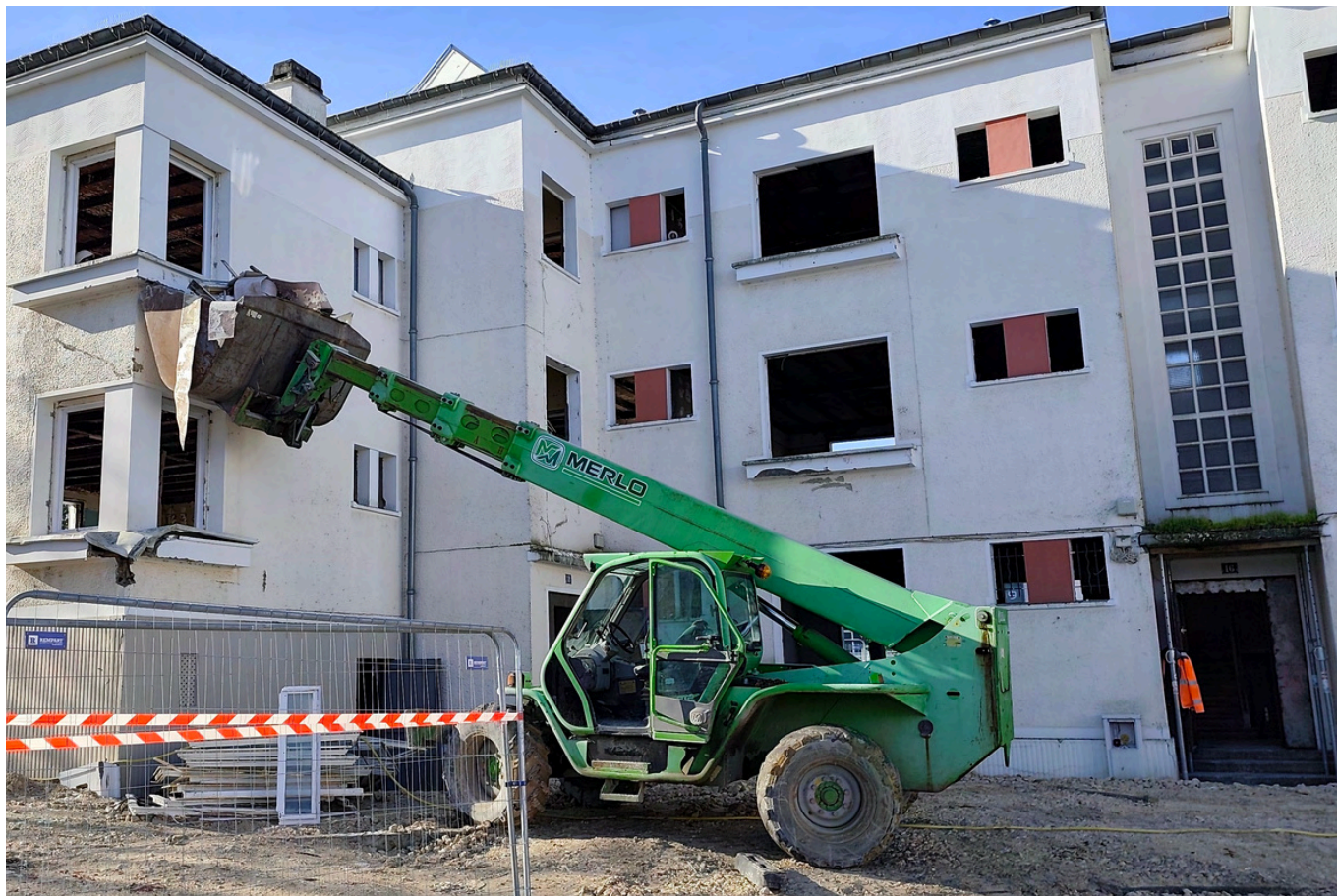
Phase de curage et désamiantage - février 2026 - Val de Berry
