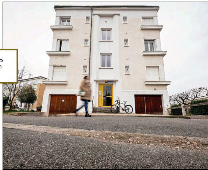
DÉMOLITION. Des immeubles et pavillons individuels vont devoir être détruits dans le quartier de l'Aéroport pour des raisons de sécurité. PHOTO PIERRE DELORÈLE
