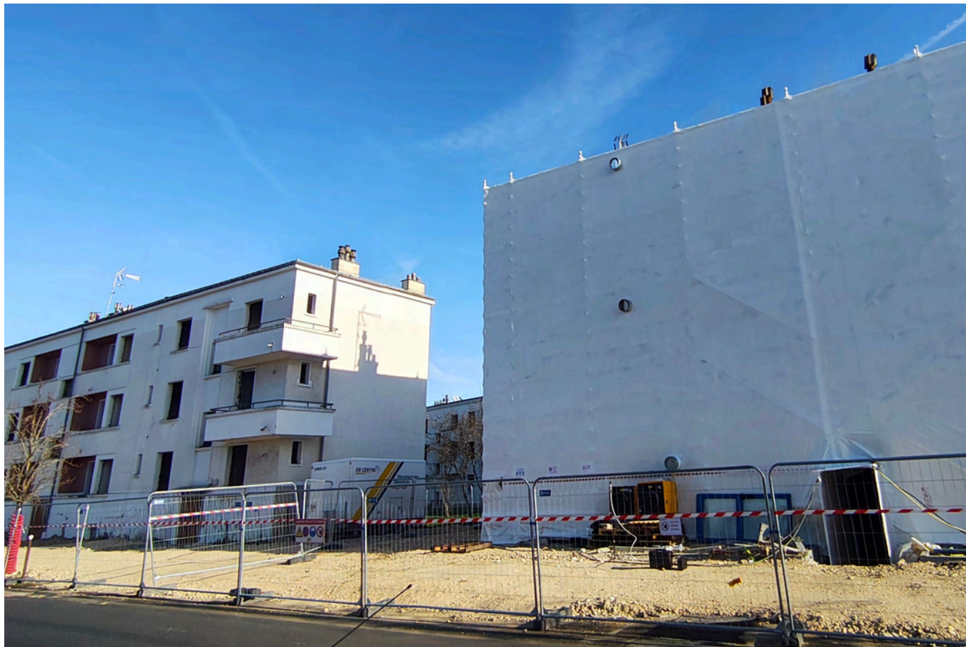
Curage de bâtiment - mars 2026 - Val de Berry
