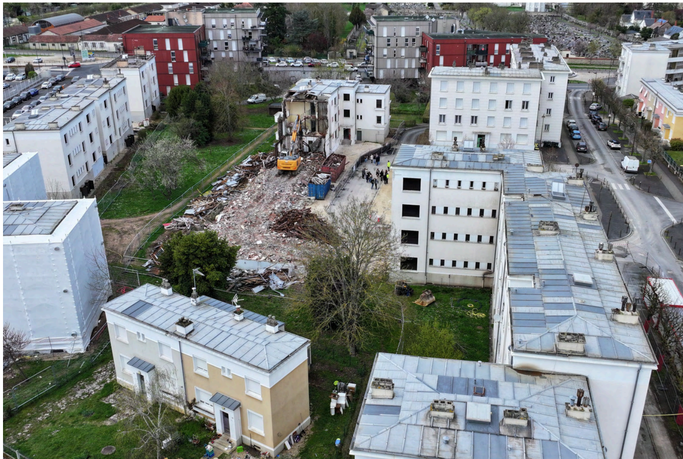
Démolition du premier bâtiment - mars 2026 - Val de Berry
