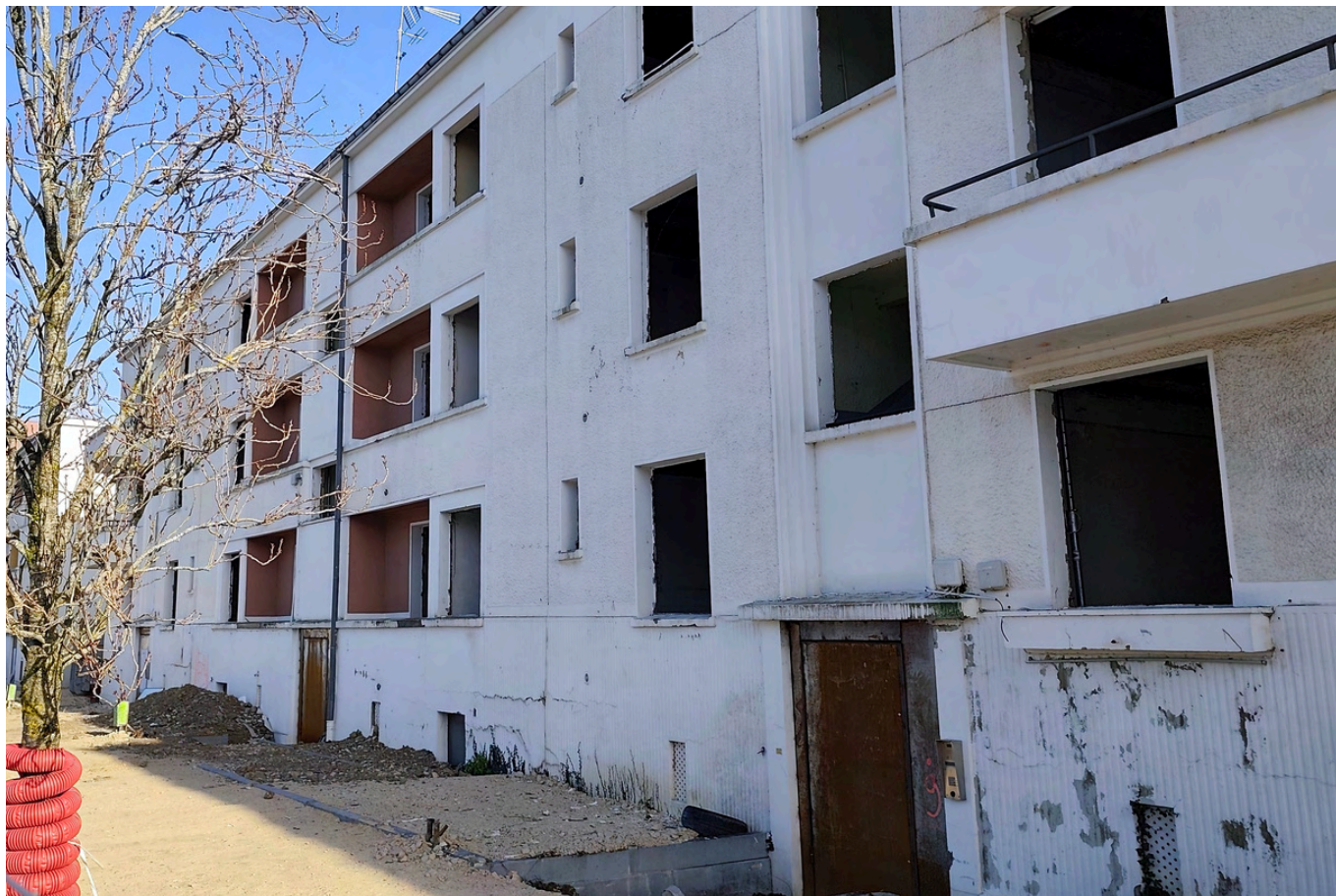
Sécurisation des bâtiments - février 2024 - Val de Berry
