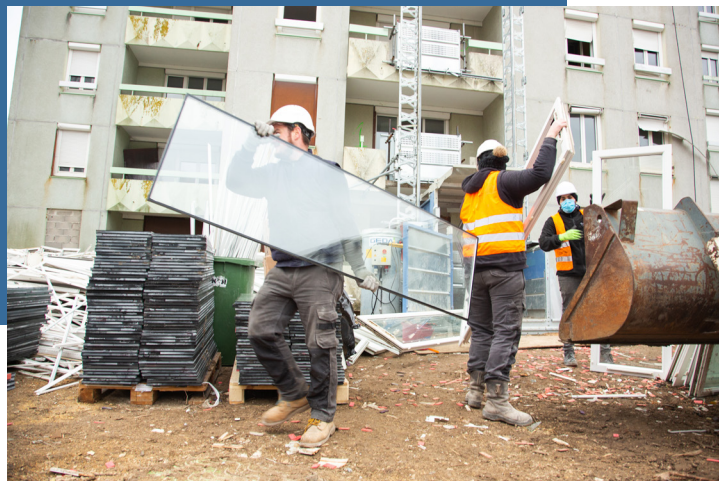
Préparation de la démolition par foudroyage de 3 tours au Moulon - Dane Apache - 2021
