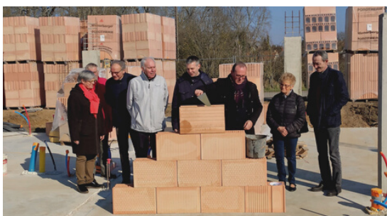
Pose de première pierre - La Guerche-sur-l'Aubois
