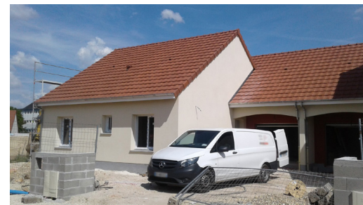
Chantier de construction d'Aubigny-sur-Nère - été 2018 - OPH du Cher
