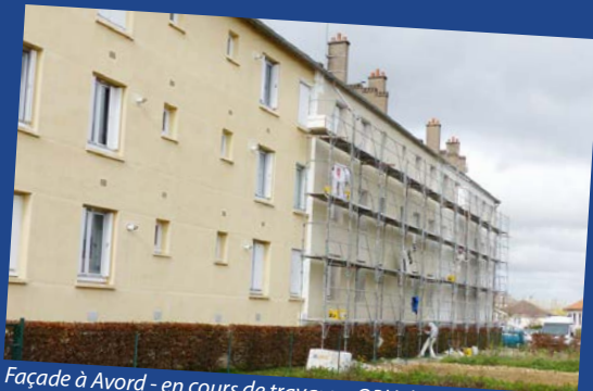
Façade à Avord - en cours de travaux - OPH du Cher 2016
